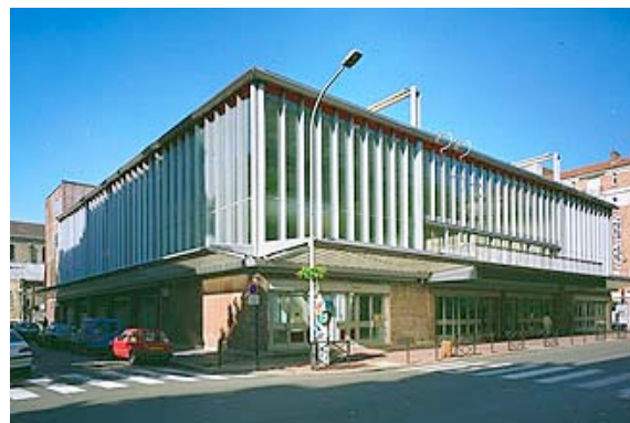
le bâtiment après travaux
