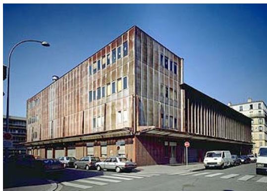
le bâtiment avant travaux
