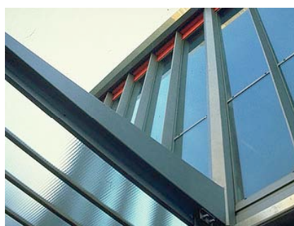
détail de la façade métallique
