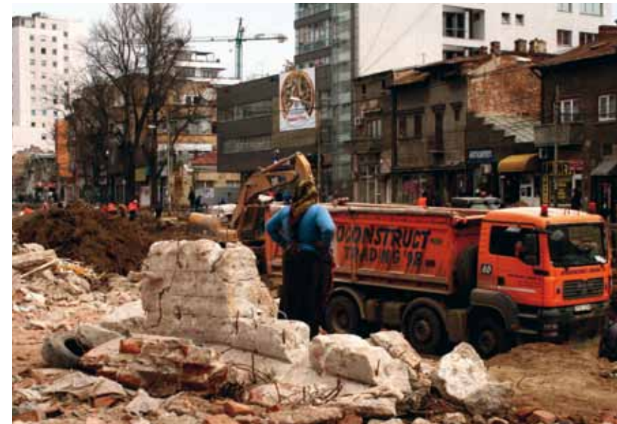
Démolition dans le quartier du marché Matache
